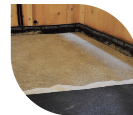
Posa di materassini acustici Misurazione di rumori da calpestio
